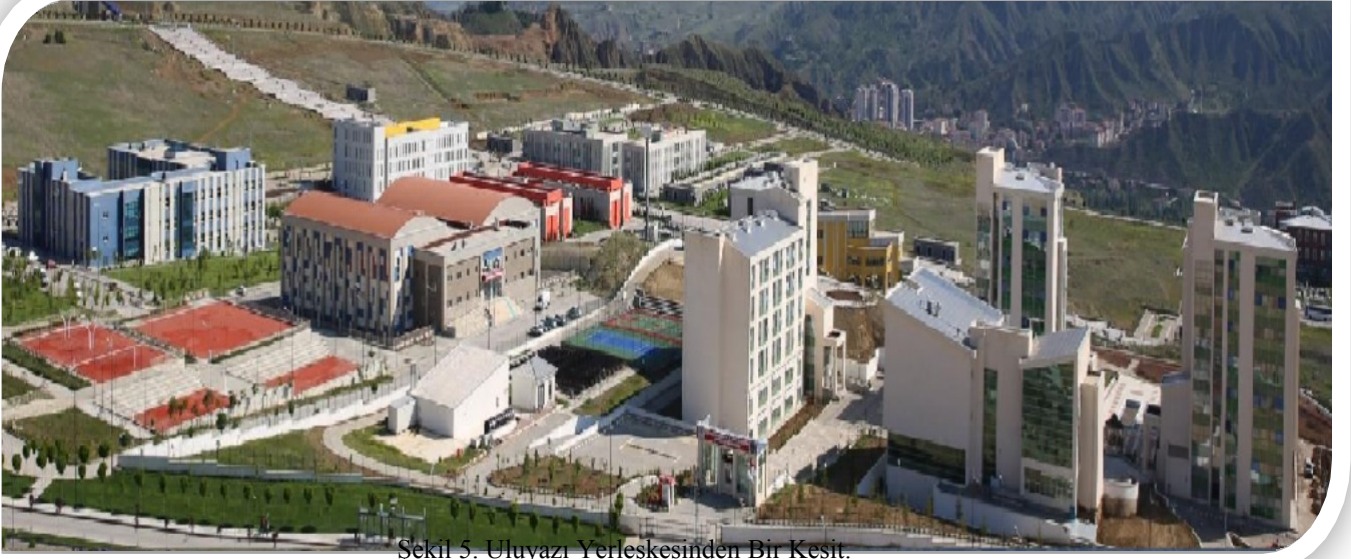
Şekil 5. Uluyazı Yerleşkesinden Bir Kesit.
